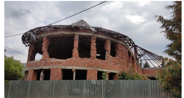
Стан до реконструкції
